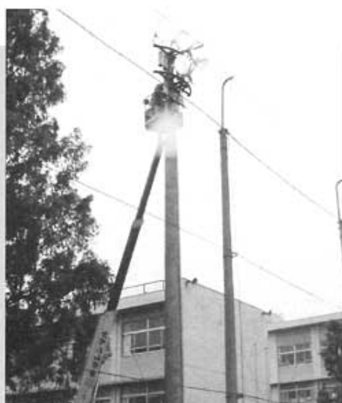
高所作業車を使っての点検作業 坂戸高校で
